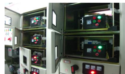
图 3 比赛场馆空调机组控制柜横装产品在场馆比赛前、比赛中、比赛后的巡检、调试、检测、维护过程中得到充分的体现: 快捷简便。
